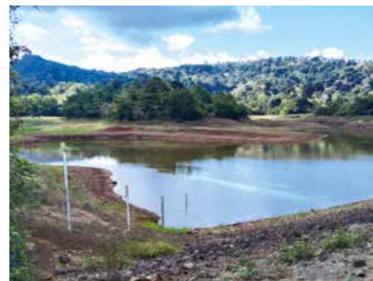
Octobre 2023: plus que 15 jours de stockage d'eau dans la retenue de Dzoumogné (Mayotte)
